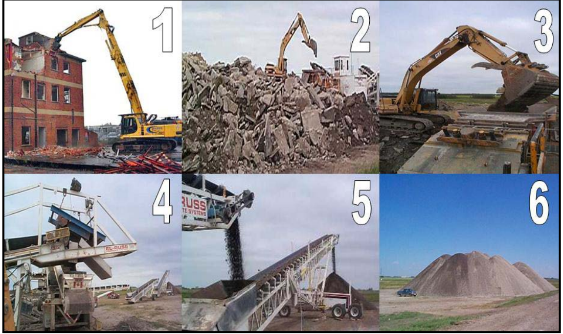
Şekil 2.1. Geri kazanılmış agrega üretim süreci (Tüfekçi 2011)
