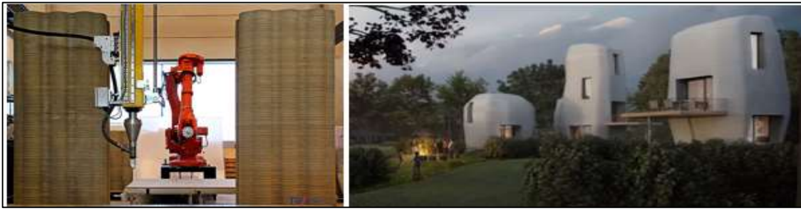
Şekil 11. TU Eindhoven üniversitesi 3D beton yazıcı cihazı ve dünyanın ilk ticari 3D beton baskı ev projesi (Anonymous 2020e).
