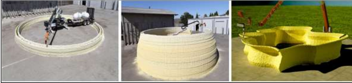
Şekil 14. MIT' de genişletilebilir köpük kullanılarak üretilen çerçevesiz 3D baskı modeli (Anonymous 2020h)
