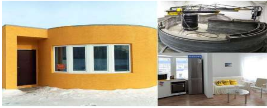
Şekil 12. Apis Cor şirketi tarafından Rusyada üretilen 3D beton baskı ev (Anonymous 2020f).
