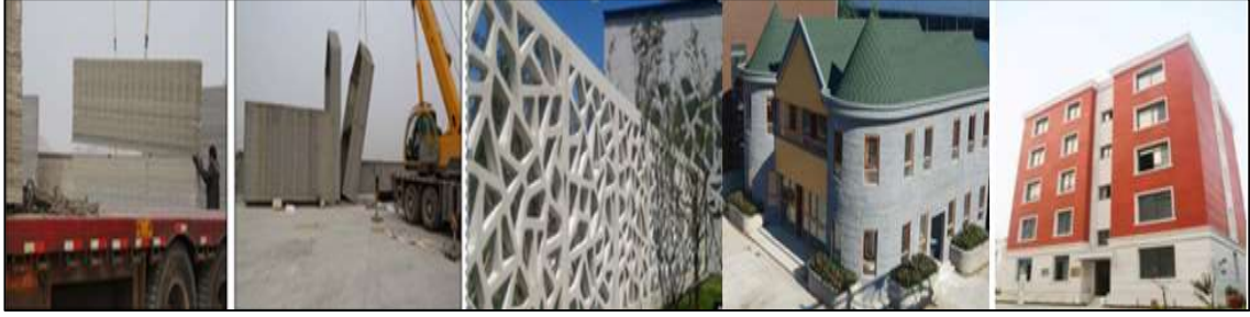
Şekil 9. Winsun şirketi tarafından üretilen 3D elemanlar, duvar örneği ve çok katlı 3D yapılar (Anonymous 2020c)
