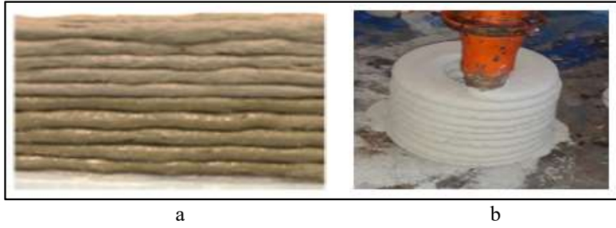
Şekil 23. (a) yeterli inşa edilebilirlik özelliği göstermesi için 10 dakika içinde 10 kat baskılı tabaka dökülmesi uygundur (Bao et al. 2018), (b) tez kapsamında üretilen 3D betonun inşa edilebilirlik özelliğinin gerçekleşmesi.
